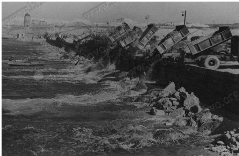
Будівництво Каховської ГЕС. Перекриття русла. Вихід банкета з води. 1955 р.
